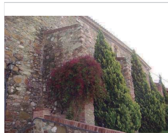
Contraforts en la façana de ponent JAP
